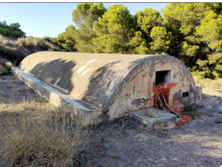
Aljibe de Terque, ubicado en el Cerro Milano.
