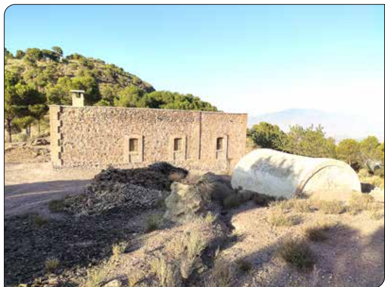
Aljibe de la "Caseta de la Luz", en Cerro Milano.
