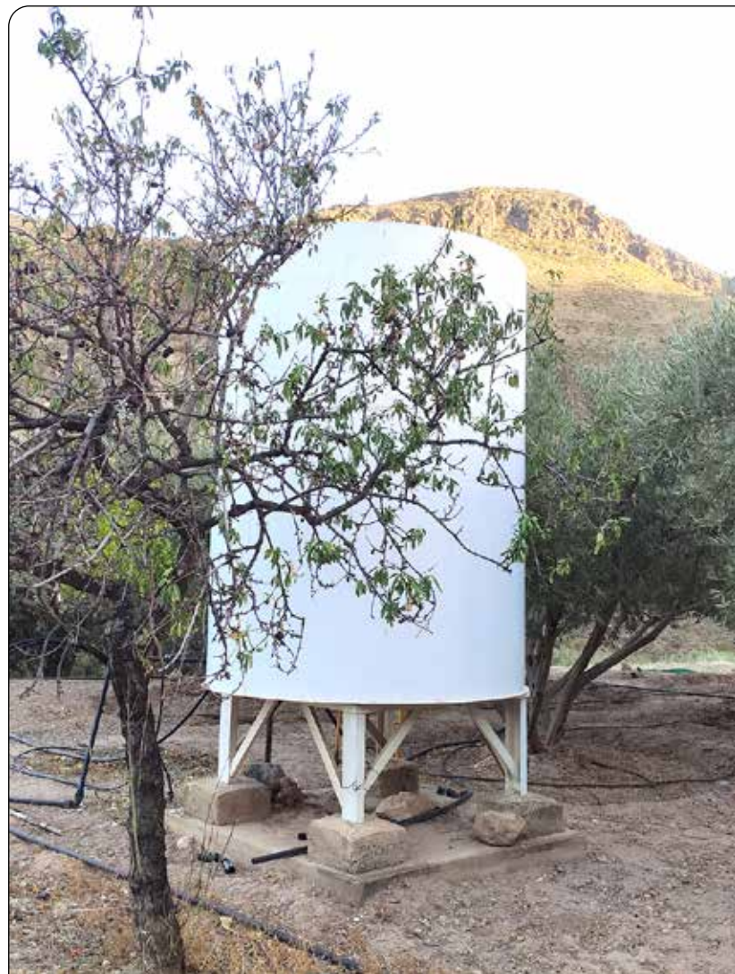
Aljibe instalado en la Fuente del Moral para dar agua a cortijos de la zona.
