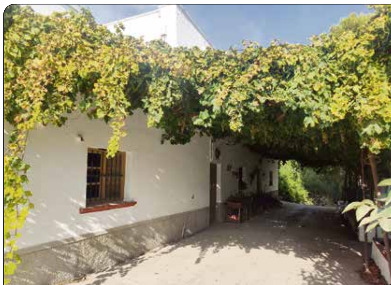
Aljibe del cortijo Los Frailes donde se observa en la parte izquierda de la fachada la canalera de evacuación.
