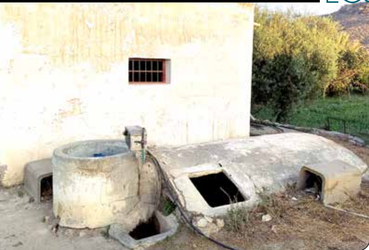
Aljibe del parral que se encontraba más al fondo de la finca. Obsérvese el pilón para los sulfatos construido con posterioridad.
