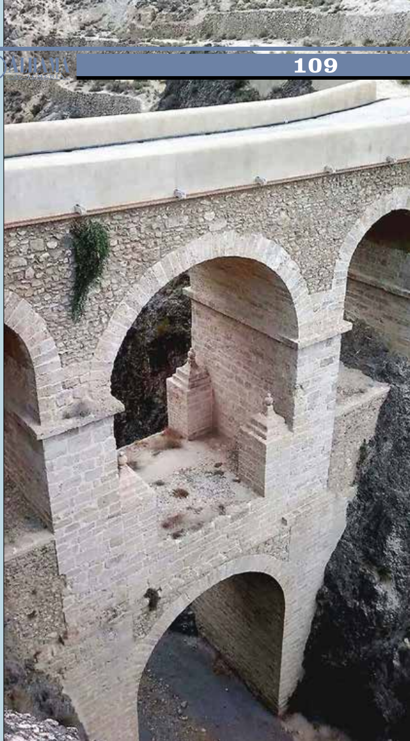
Detalle que muestra la grandiosidad de esta obra civil del siglo XVIII una vez restaurada. Colección particular.
