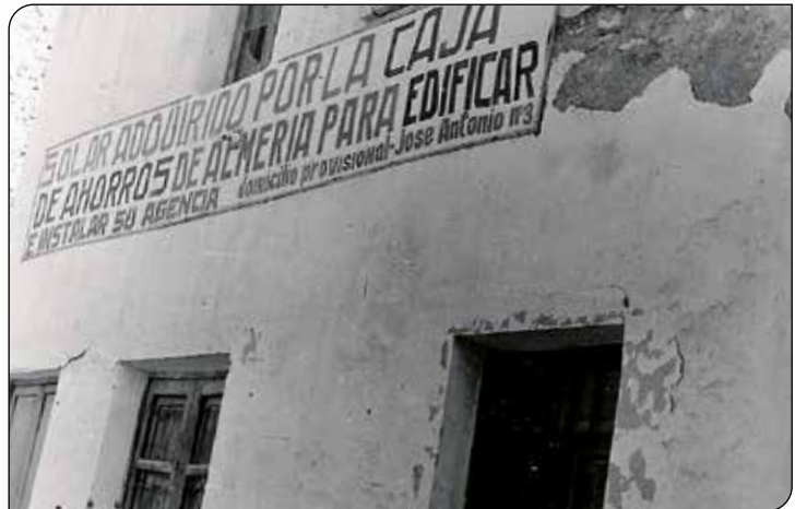
Vivienda adquirida por la Caja de Ahorros de Almería para la instalación de sus nuevas oficinas en la calle de los Médicos Rodríguez e Ibáñez. Colección particular familia Barquero Artés.
