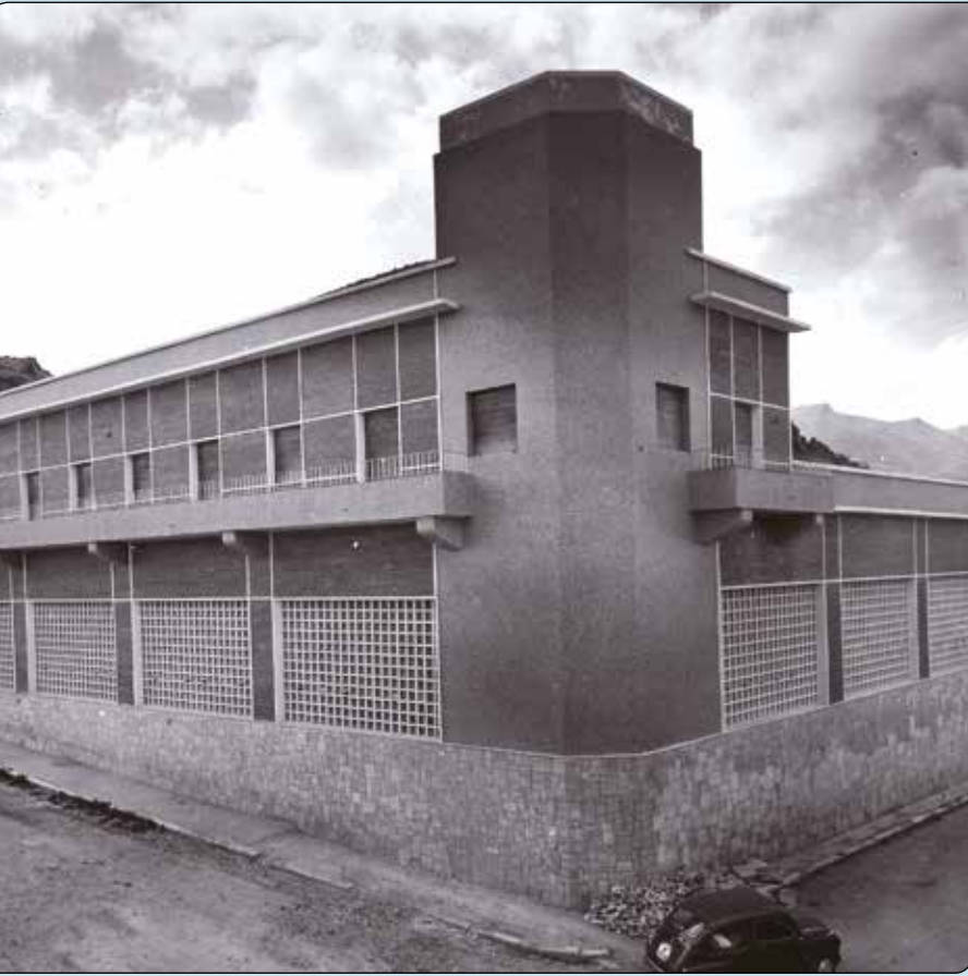
Fabrica y viviendas, hoy desaparecidas, construidas por Artés de Arcos en la calle Ramón y Cajal de Alhama de Almería. Año 1964.
