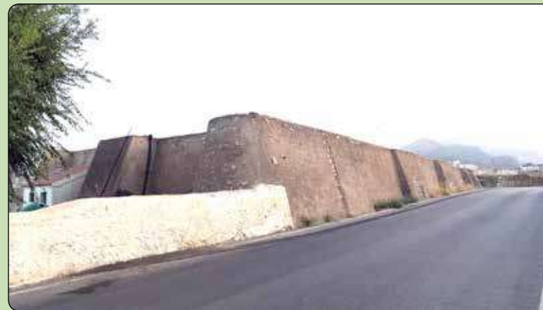
Detalle de los robustos muros en talud y contrafuertes de la Balsa Venta Tortosa.
