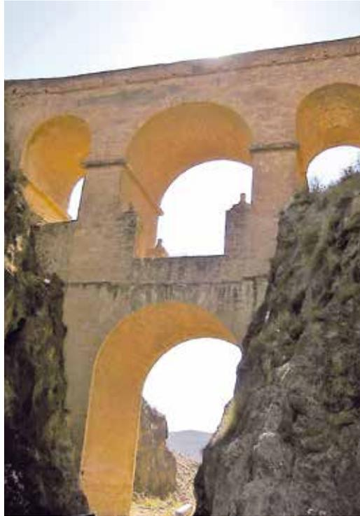
La puente de Alhama, un puente de estilo neoclásico, de aproximadamente 26 m de altura, 45 m de longitud y unos 7 m de luz en el vano central.
