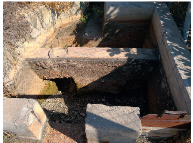
Partidor Nicolás Marín, donde se observa a la perfección la estructura de estas construcciones cuya misión era partir el agua equitativamente hacia los ramales de salida.
