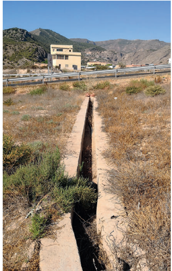
Trozo de cauce que llevaba el agua desde Malaguilla hasta la Cueva del Doctor. En la actualidad se encuentra anulado por el la construcción del nuevo nudo de entrada al pueblo.
