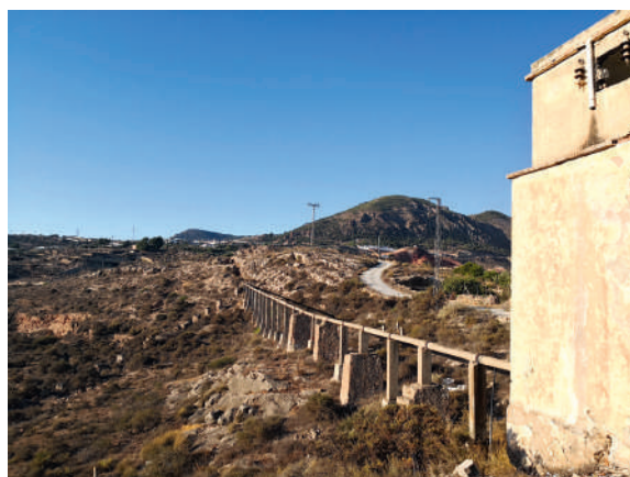
Tramo de acueducto que subía el agua desde "La Maquina" hasta La Pipa.
