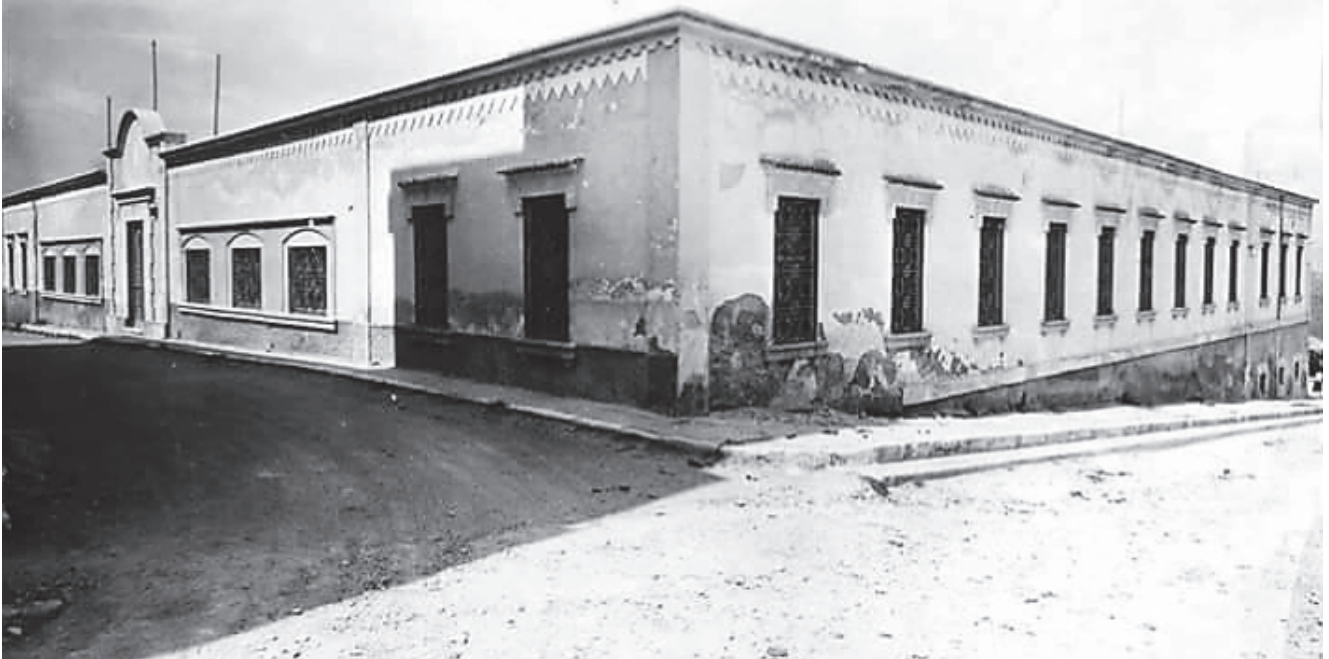
Vista del Balneario San Nicolás en Alhama de Almería anterior a la reconstrucción realizada por Artés de Arcos.
