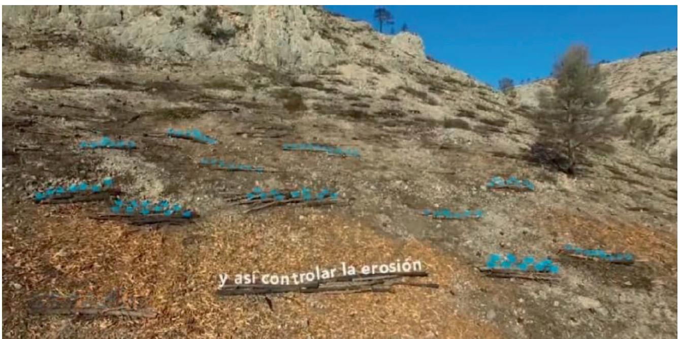
Disposición de las fajas en la ladera a fin de maximizar la retención de agua y suelo. (Fuente: La Cámara Roja).
