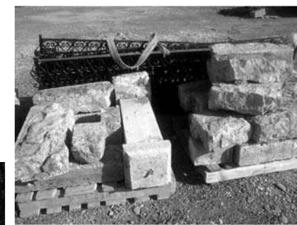
Barandas, piedras y balaustres del desmantelado templete que albergaba la escultura de don Nicolás.
