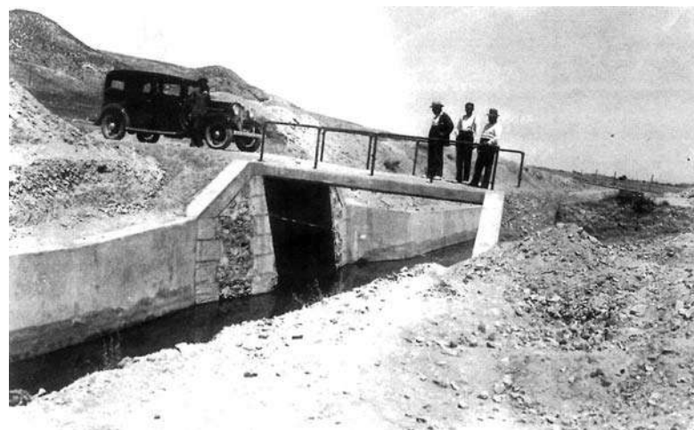
José Salmerón revisando el Puente de Román López, tramo en rehabilitación de la acequia del Jarama en el mes de julio de 1934. Col particular familia Salmerón.
