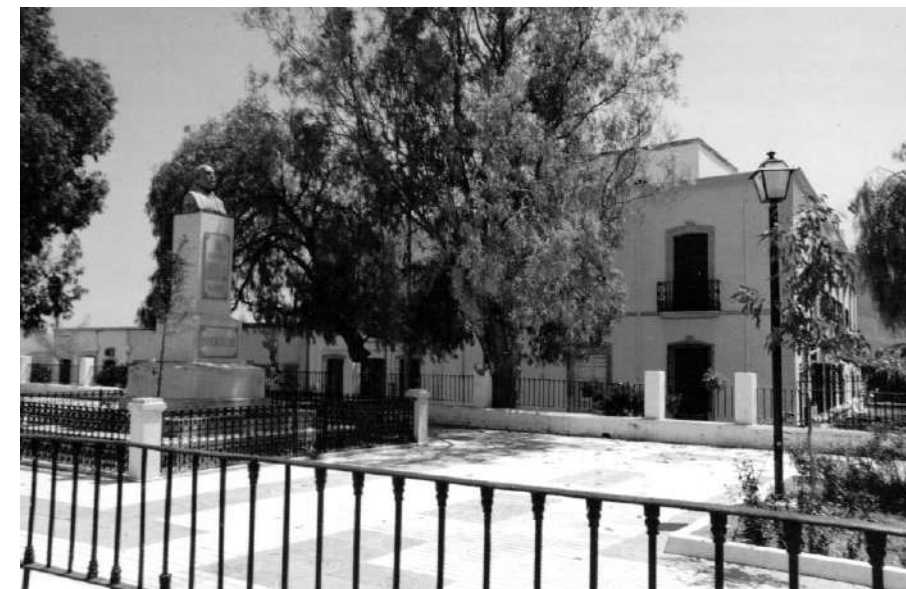
Vista del Paseo Nicolás Salmerón anterior a su destrucción. Año 2007.
